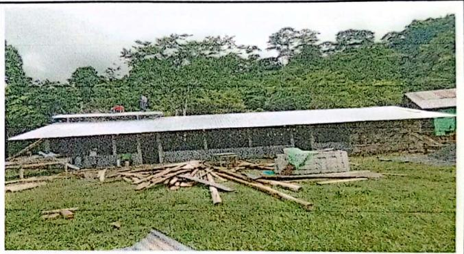
Foto 4: Colocación de estructura metálica y entechado con láminas trqueladas
