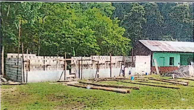
Foto 3: Remozamiento de la solera y columnas
