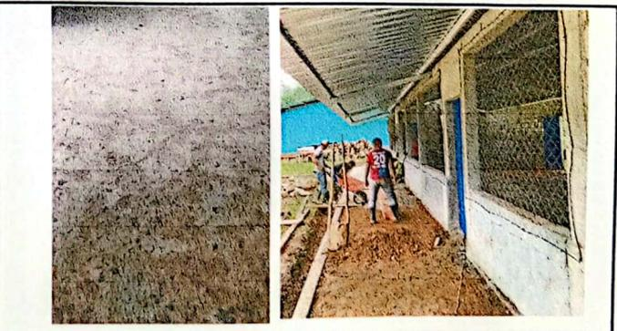
Foto 6: Fundición de piso con una torta de cemento
